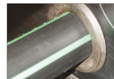
Rohranbindung mit Dichtung 0,5 bar wasserdicht
