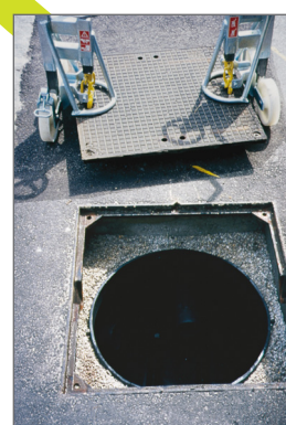
Dichtes Schachtabdeckungssystem mit getrennter Dicht- und Tragfunktion
