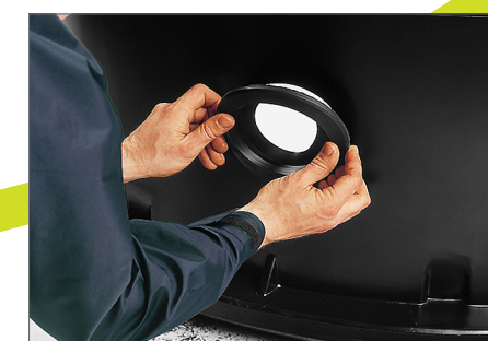
Dichtung einsetzen
