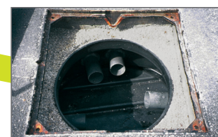
Dichtes Schachtabdeckungssystem mit getrennter Dicht- und Tragfunktion
