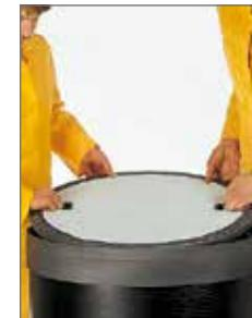
bern und mit der ROMOLD Elementdichtung am unteren Bauteil zusammenfügen. Die Schachtbauteile werden bis zum Anschlag mittels Körpergewicht bzw. mit geringer Auflast miteinander verbunden.
