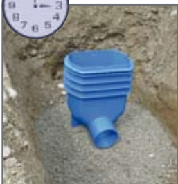
3. Minute: Schacht auf Magerbeton setzen
