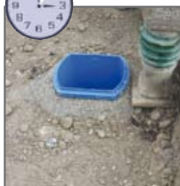
7. Minute: Verfüllen und verdichten
