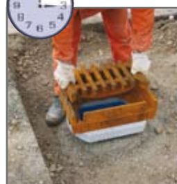
15. Minute: Aufsatz aufsetzen
