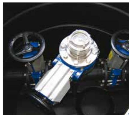
Spülschacht DN 1000 mit 3 Schieber
