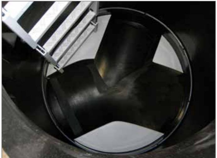
Schacht DN 1000 Gerinne DN 500 + seidl. Zulauf DN 400
