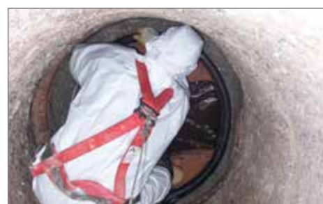
6.) Aufsetzen der ROMOLD Elementdichtung auf Montagering. 100 % dichter Übergang auf Schachtbauteile
