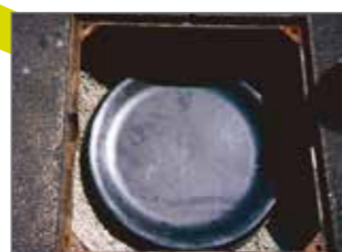
Dichtes Schachtabdeckungssystem mit getrennter Dicht- und Tragfunktion
