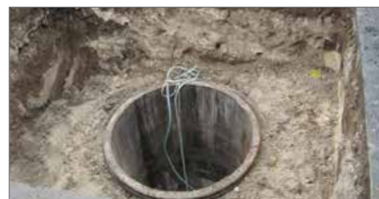
1.) Asphalt aufschneiden, Betonkonus abheben
