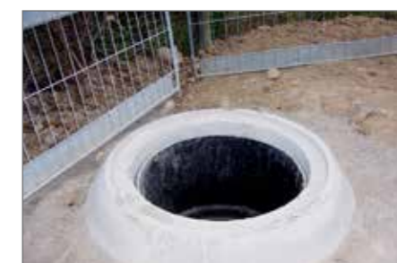
10.) Verfüllen des Zwischenraums. Wiederherstellen des Straßenaufbaus inkl. lastentkoppelter Abdeckung.
