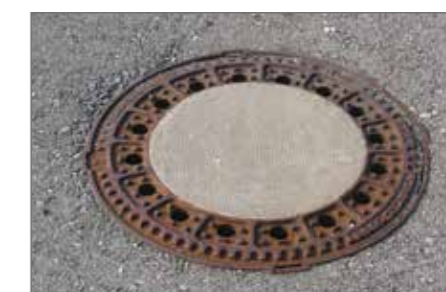
12.) Wiederherstellen des Straßenaufbaus und der Straßenoberfläche inkl. lastentkoppelter Abdeckung.
