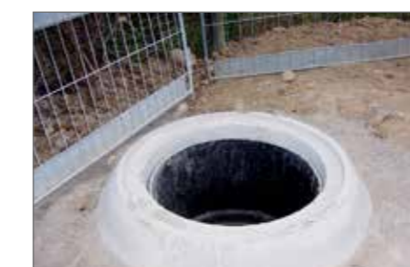
11.) Lastentkoppelte Abdeckung.
