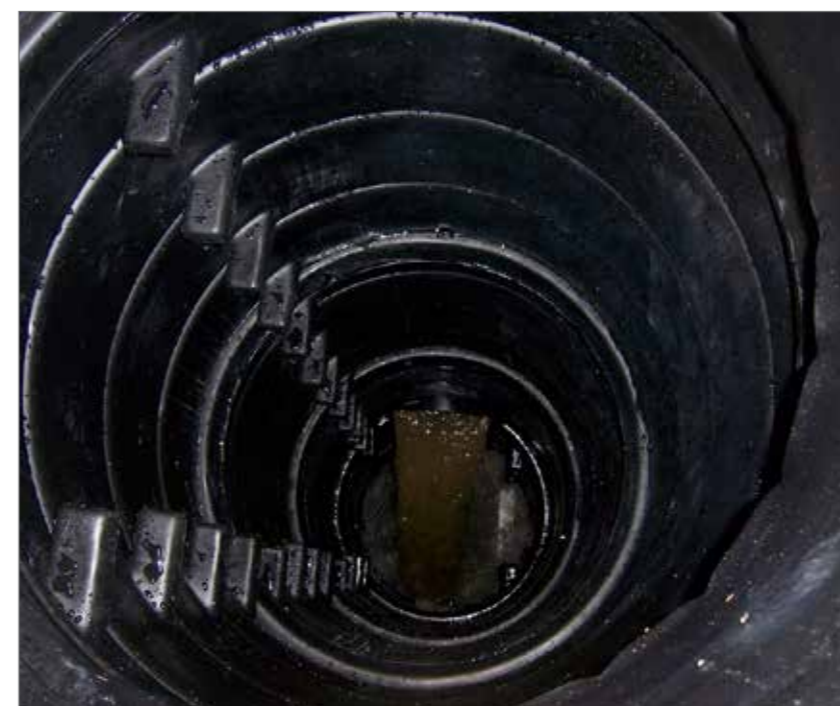
9.) Fertig sanierter Schacht. Steigstufen wurden auf Kundenwunsch entfernt.
