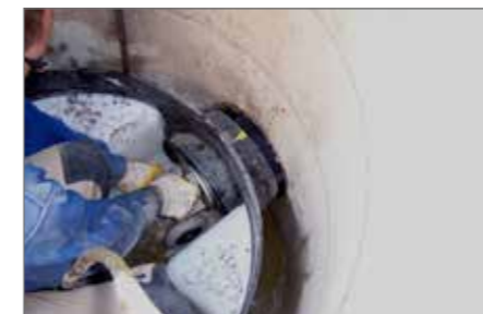
6.) Absperriblenden in Ablauf und Zuläufen setzen, Verfüllen des Zwischenraums mit modifiziertem Verfüllmörtel
