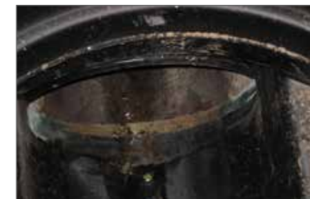
Anbindung der PE-Stützen an das Altrrohr erfolgt mit Verfüllmörtel
