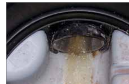
7.) Nach Aushärten des Verfüllmörtels kann die Wasserhaltung abgebaut werden
