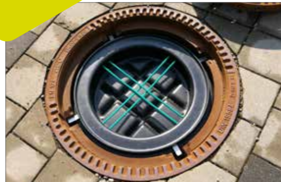
Activ-Filter für Kanalschächte im Einbau
