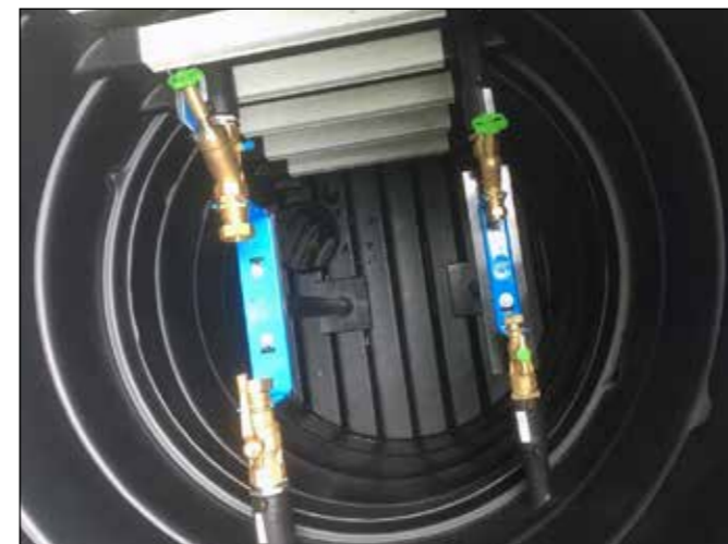
Doppelwasserzählerschacht
