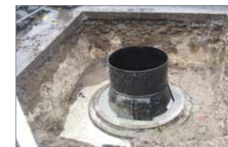
9.) Verfüllen des Zwischenraums zwischen PE-Schacht DN 800 und Betonschacht DN 1000 mit Verfüllmörtel
