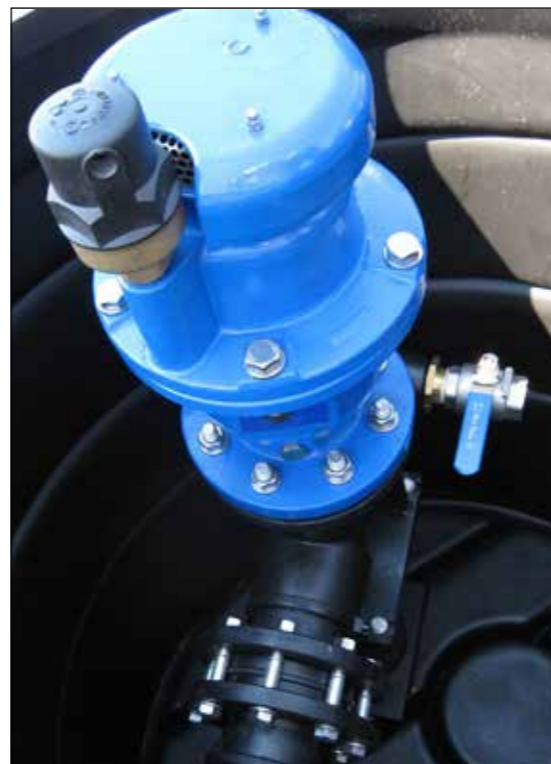
Be- und Entlüftungsventil mit Entleerungsmöglichkeit
