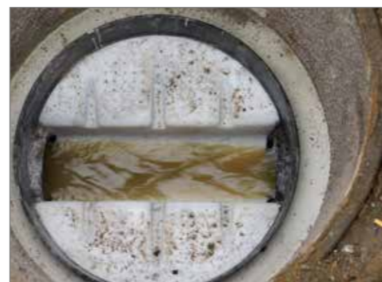
Schacht-in-Schacht Sanierung
