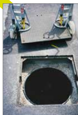
Dichtes Schachtabdeckungssystem mit getrennter Dicht- und Tragfunktion
