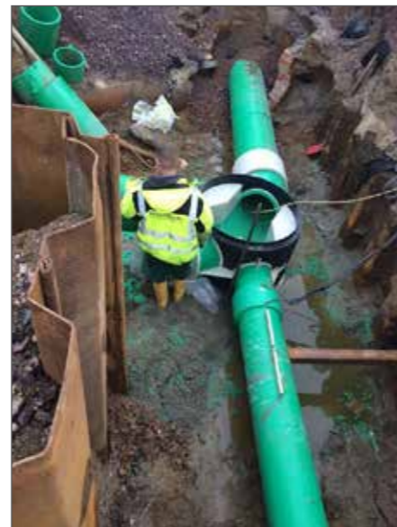
Sanierung Kanal – PP-Schacht und PP-Rohr verschweißt
