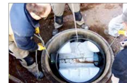
5.) Vorgefertigtes Gerinne in Schacht einbringen
