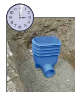
3. Minute: Schacht auf Magerbeton setzen
