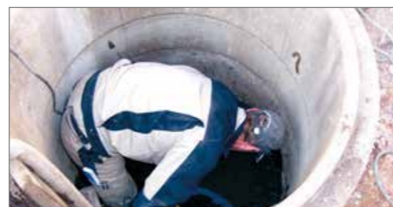
2.) Steigstufen entfernen, Berme und Gerinne abstimmen, Wasserhaltung, Überpumpbetrieb einrichten
