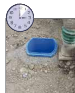
7. Minute: Verfüllen und verdichten
