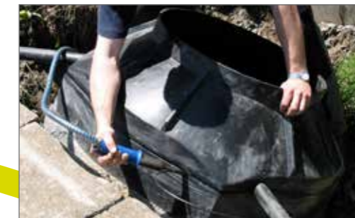
Trennen und Wiederschweißen möglich
