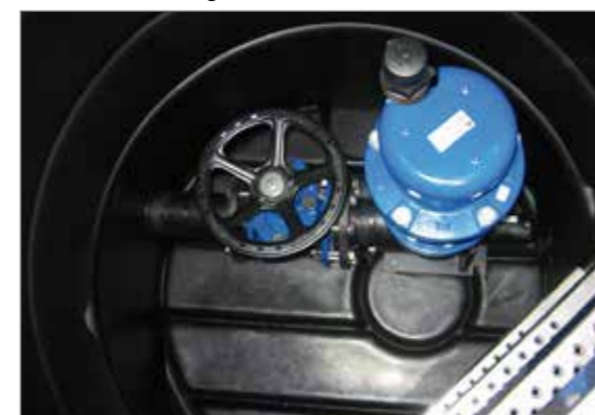
Be- und Entlüftungsschacht als Seitenanschluss
