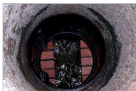
8.) Aufsetzen der PE-Schachtbauteile Schachtsystem DN 800 und Elementdichtungen
