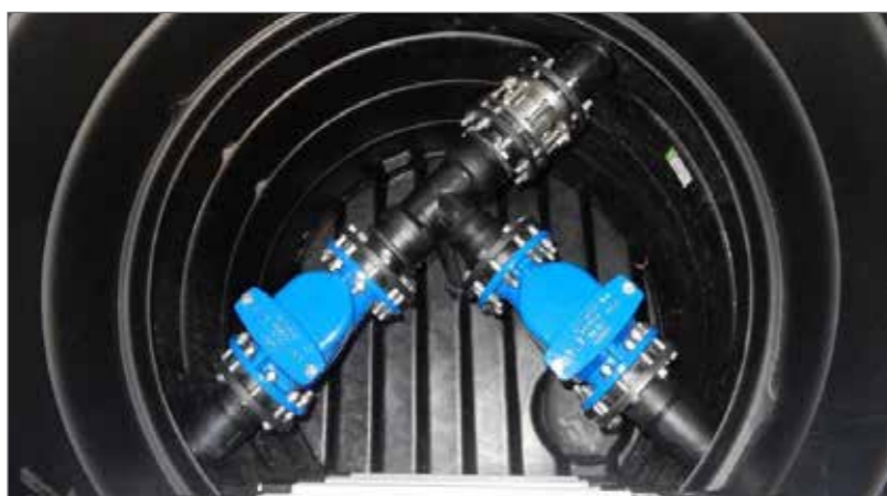
Abzweig mit Rückschlagklappen
