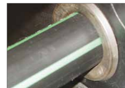
Rohranbindung mit Dichtung 0,5 bar wasserdicht
