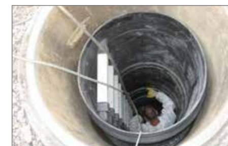
8.) Aufsetzen der Dichtungen und Schachtbau- teile – PE Schachtsystem DN 800
