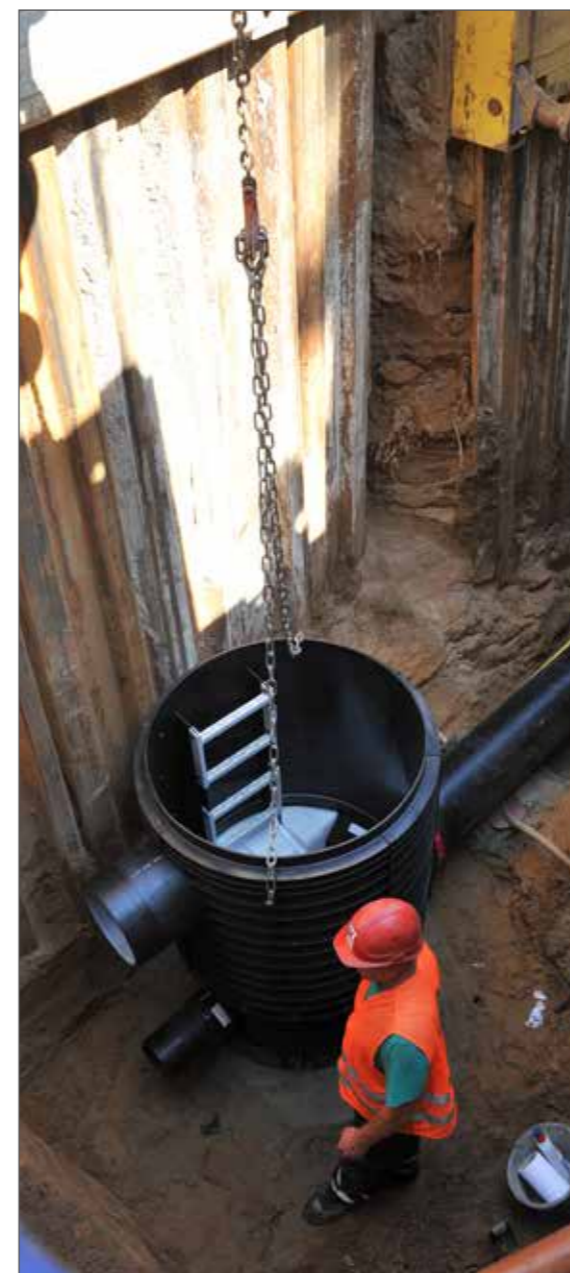
Absturzbauwerk – verschweißtes PE-System
