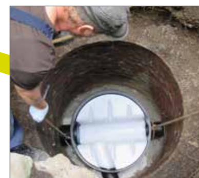
Neuen Boden in den Schacht ablassen
