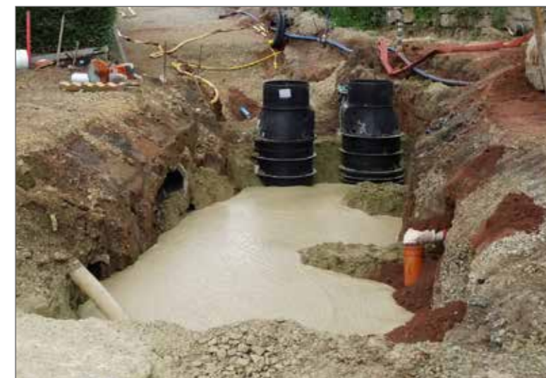
Schachteinbau in Flüssigboden
