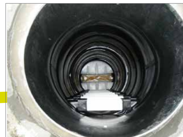
Neuer PE-Schacht DN 800 in korrodiertem Schacht DN 1000
