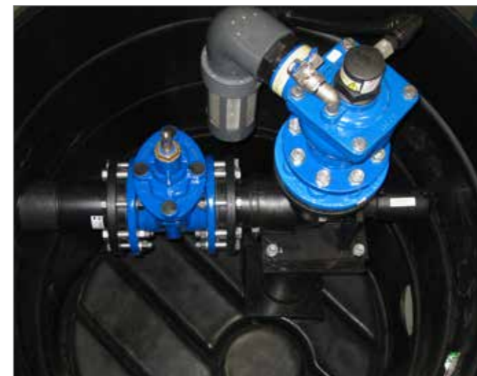
Be- und Entlüftungsschacht mit Rückstausicherung
