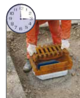
15. Minute: Aufsatz aufsetzen
