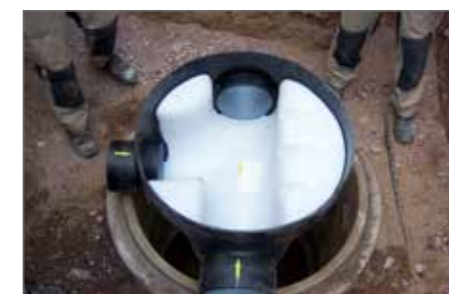
4.) Vorgefertigtes Gerinne mit PE-Stützen anpassen
