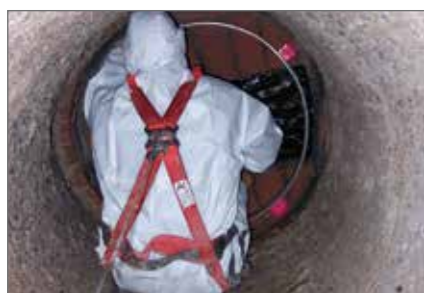
4.) Montagering auf Berme befestigen
