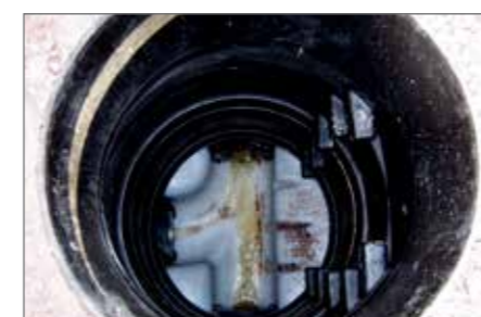
10.) Fertig sanierter Schacht. Steigstufen wurden auf Kundenwunsch nachträglich entfernt.
