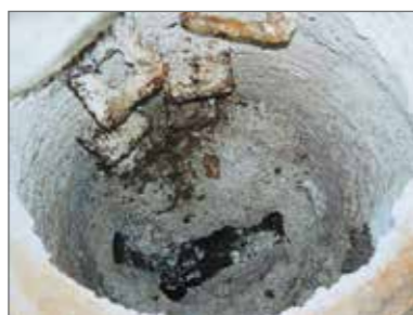
Ausgangssituation: korrodierter Betonschacht
