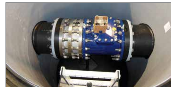
Woltmann-Zähler für PE-Rohr Da 450
