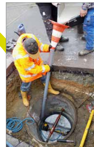
Zwischenraum verfüllen
