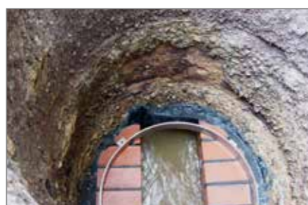
5.) Bild zeigt befestigten Montagering
