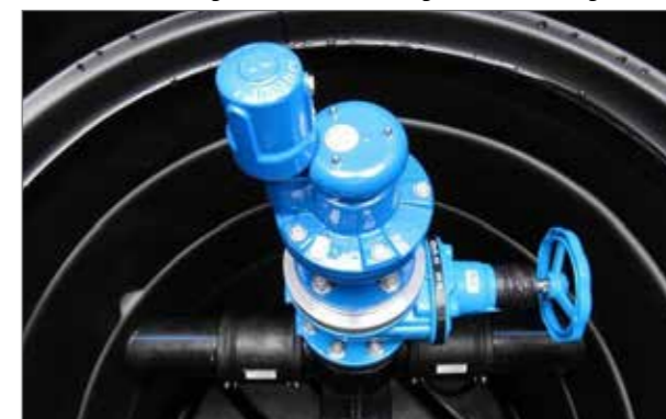
Be- und Entlüftungsschacht mit durchgehender Leitung
